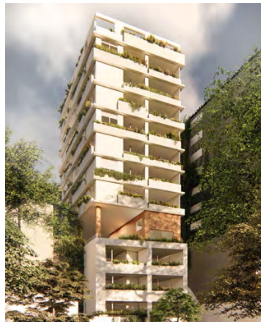
Ed. Vista por Felipe Hess Arquitetos
